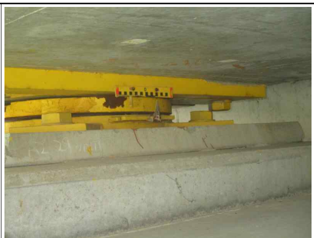
받침 이동위치 측정(2)
