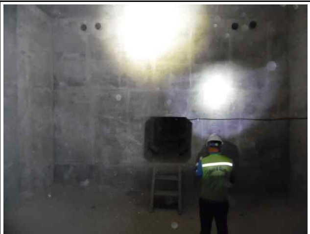
도보를 이용한 외관조사(춘천방향)
