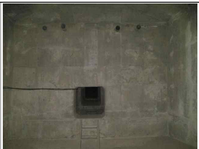
PSC 박스거더(내부) 전경(2)
