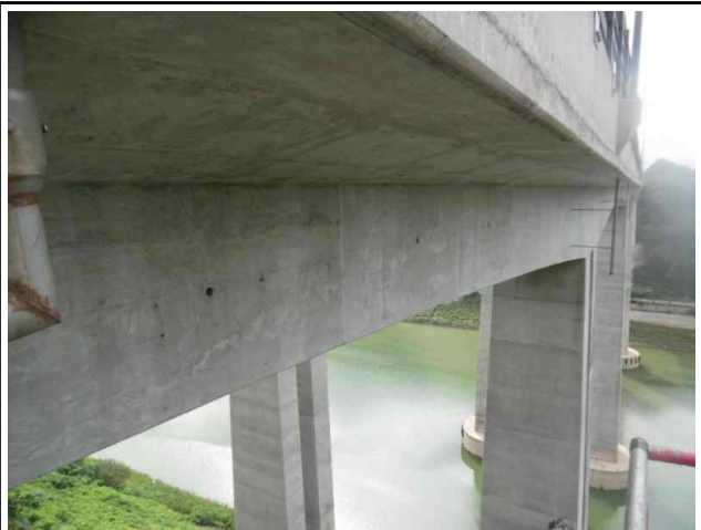
PSC 박스거더(외부) 전경(2)
