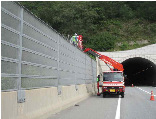
교량점검차를 이용한 외관조사(부산방향)
