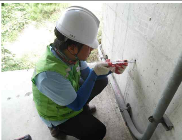
탄산화 깊이 측정
