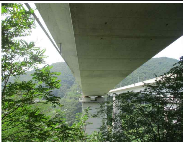
PSC 박스거더(외부) 전경(1)
