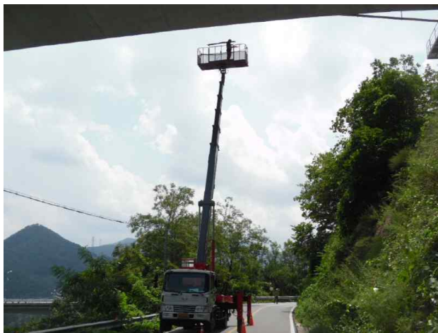
고소작업차를 이용한 외관조사(부산방향)
