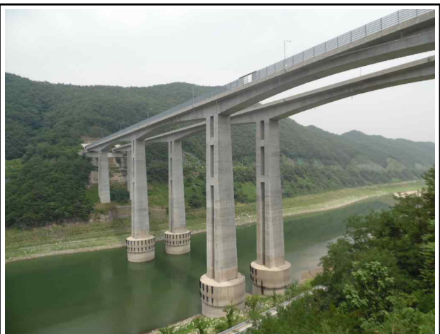
PSC 박스거더(외부) 전경 (2)
