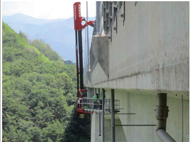
교량점검차를 이용한 외관조사(춘천방향)
