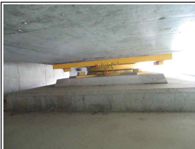
받침 이동위치 측정(1)
