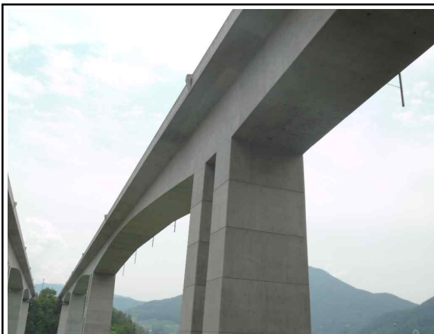
PSC 박스거더(외부) 전경 (1)
